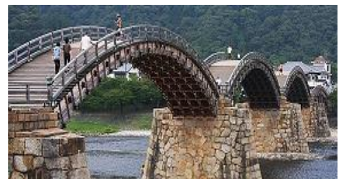
Iwakuni Kintai Bridge
