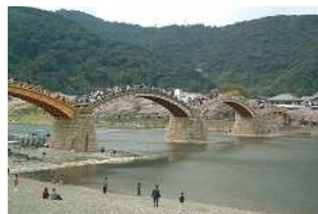
Iwakuni Kintai Bridge
